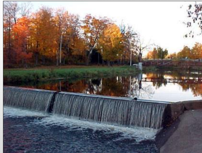
OUVRAGE DE RETENUE
